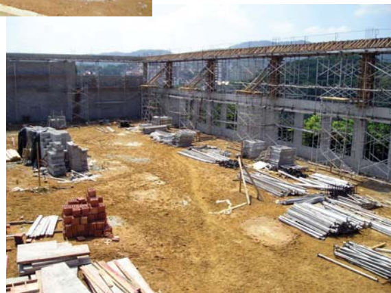
As obras para construção do ginásio ocupam 1.800 m 2
