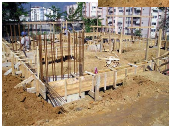
Espaço onde serão erguidas as salas de apoio
